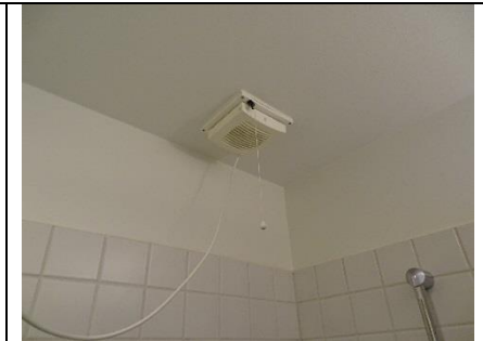
Eksempel på mekanisk ventilation i badeværelse
